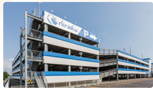
ニラク郡山大町店立体駐車場
